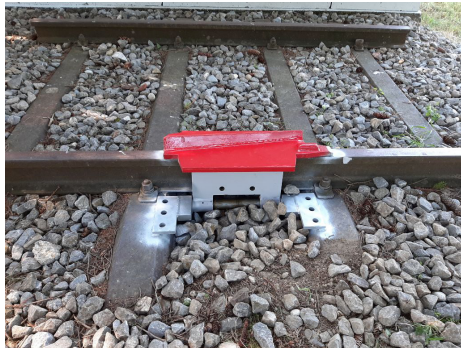
Unser Schlosserteam montierte in Lengwil einen Entgleisungsschuh an unserer Anschauungs-Gleisanlage. Weiter waren an diversen Schlössern Unterhalt nötig und in Bottighofen wurde ein Treppengeländer montiert.
