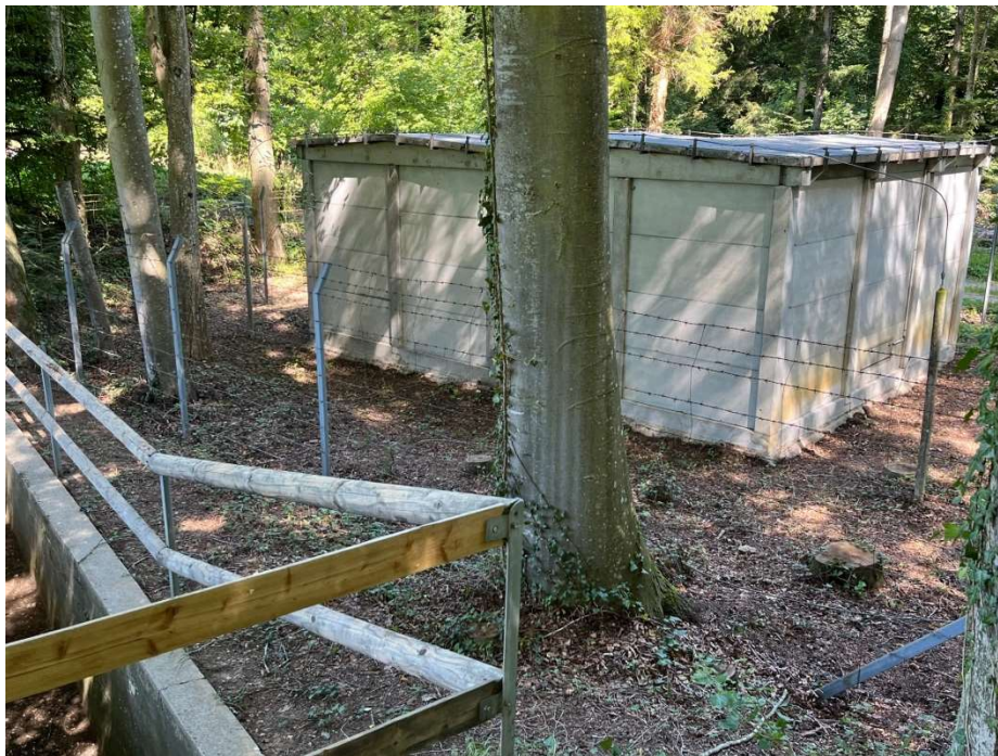
Magazingebäude und Abgang zum Fest Mw Haslibuck: Gebäude, Mauerwerk und Zäune sind frisch renoviert und in tadellosem Zustand.
