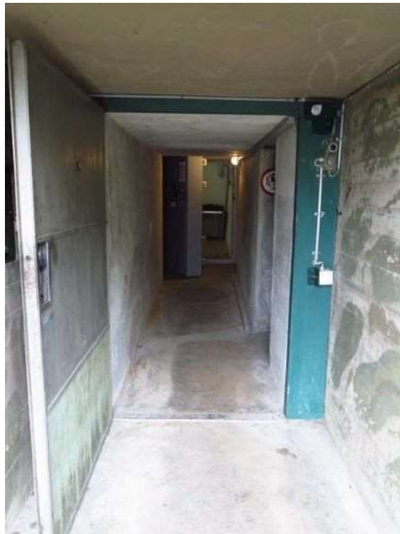
Eingangsbereich mit Panzertüren und Dem Schleusen-System
