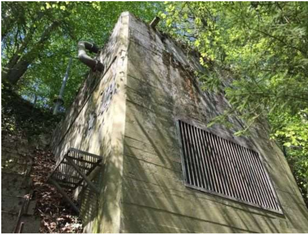
Lüftungsschacht mit Funkanschluss für Aussentruppen
