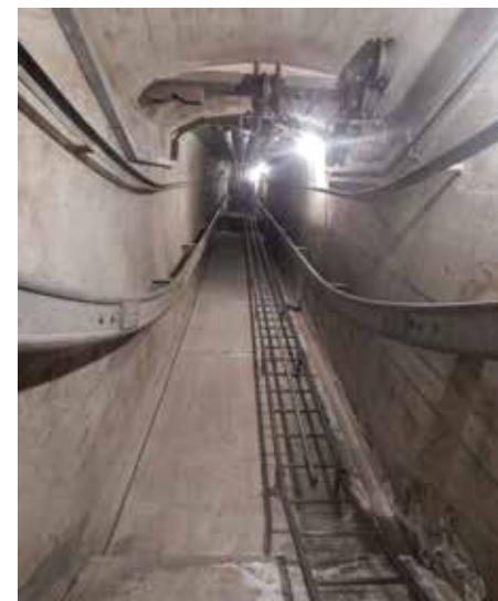
Schrägaufzug für die Turmkanone
