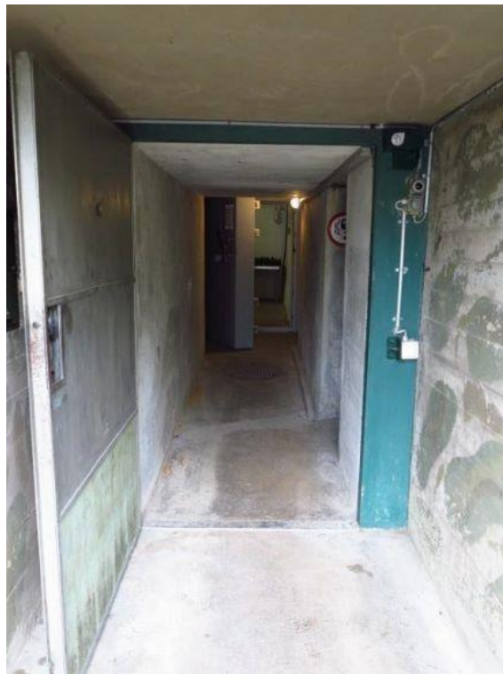
Eingangsbereich mit Panzertüren und Dem Schleusen-System
