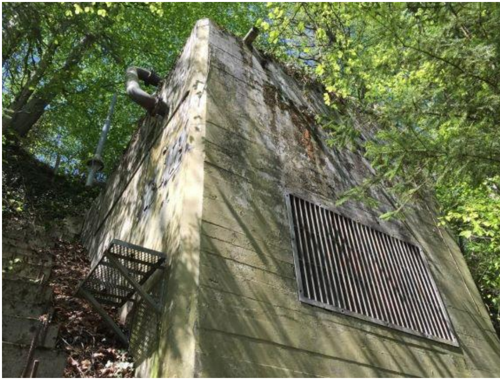
Lüftungsschacht mit Funkanschluss für Aussenstruppen
