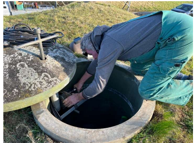
Schweissen unter erschwerten Bedingungen!
