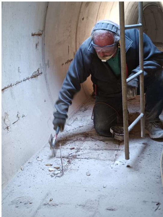
Hans Bill beim Freilegen der Armierung
