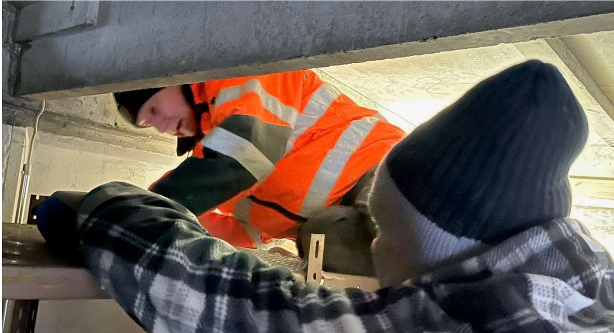
*Mühsame Montage der neuen Vergitterung der Lüftungsöffnungen.*
